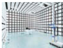
第14電波暗室 3m法
